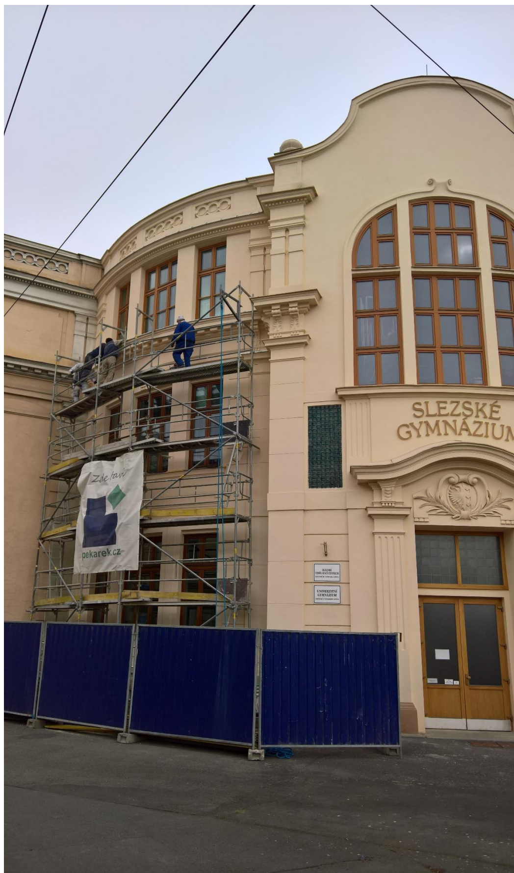
Obrázek 2 – oprava fasády, anglického dvorku a plotu
