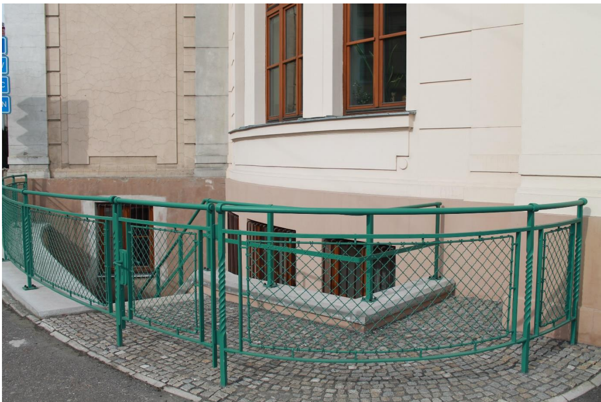
Obrázek 1 – oprava fasády, anglického dvorku a plotu
