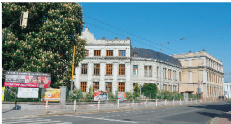
Budova Slezského gymnázia, Opava
